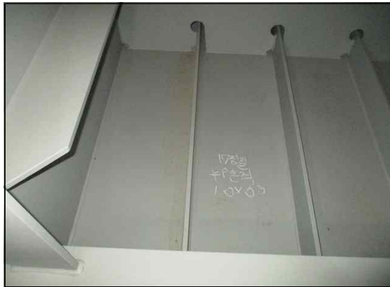
거더 내부 환기구 망 보수(S2-G1)
