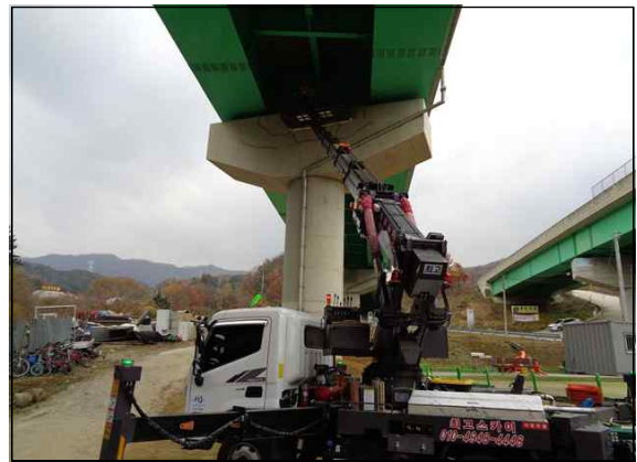
작업차량을 이용한 외관조사
