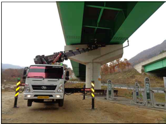
작업차량을 이용한 외관조사
